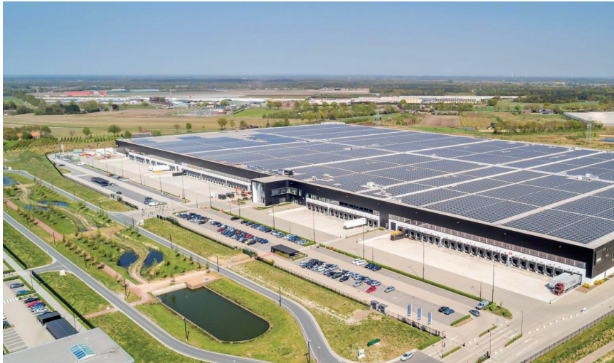
Afbeelding 4.2 Bedrijvenloos met PV-panelen op het dak (bron: greenportvenlo.nl)
