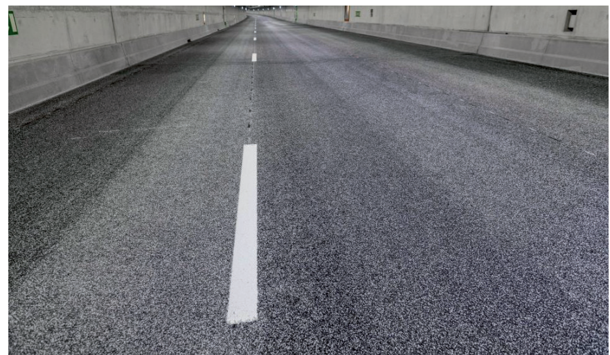
Afbeelding 4.5 Met reflecterend asfalt is minder verlichting nodig 's nachts aangezien 20% van de verlichting wordt weerkaatst en hittestress verminderd (bron: cementonline)
