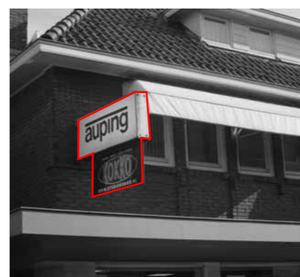
Geen plaatsing op de tweede bouwlaag...
