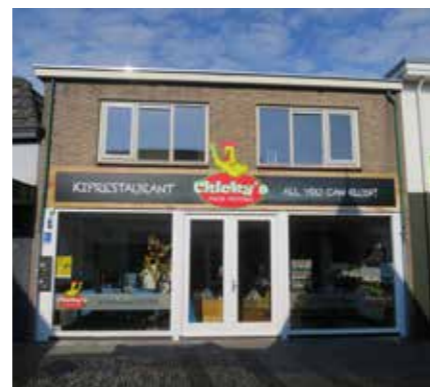
Boven: In één vlak uitgevoerde aluminium pui Midden: Winkelpui ten koste van karakteristiek pand Onder: Te weinig kwaliteit door sober materiaalgebruik
