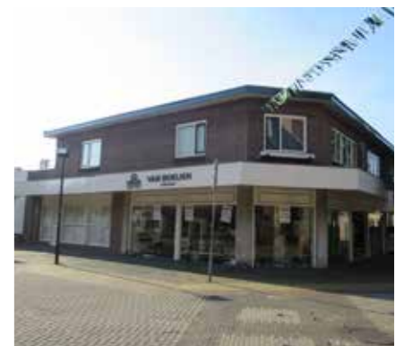
Boven: Luifel gaat 'om de hoek' en is eenvoudig uitgevoerd Midden: Forse luifel, eenvoudig uitgevoerd in trespabeplating Onder: Luifel domineert het straatbeeld
